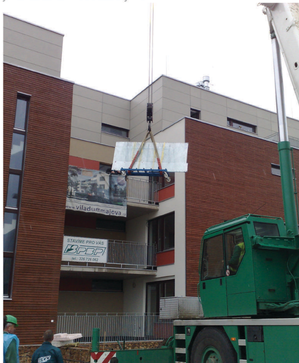
Pokaždé není montáž dveří snadná - stěhování celoskleněných dveří jeřábem na akci Viladům Májová.
