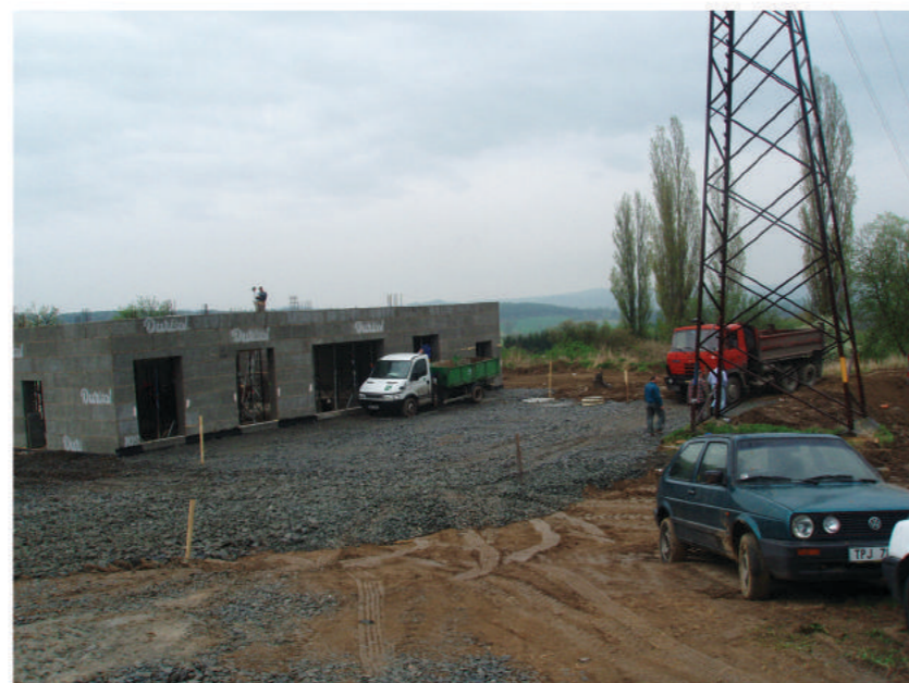
Vetos firemní budova už má první patro! Stěny tvoří systém ztraceného bednění vylitý betonem, stropy jsou betonové monolitické.
