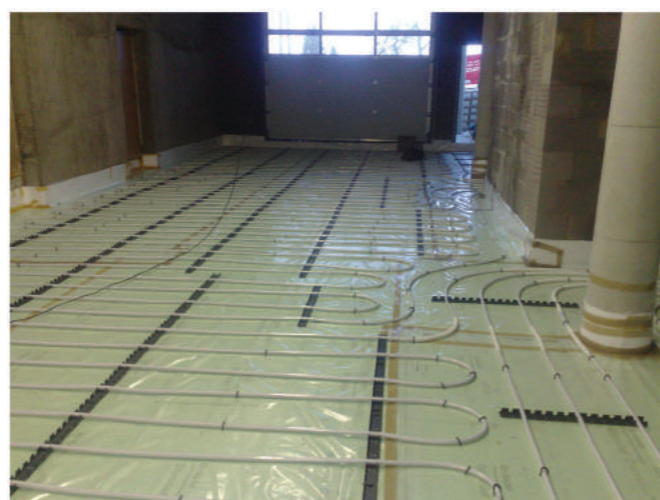
Pro vytápění skladu byl zvolen unikátní systém podlahového topení.
