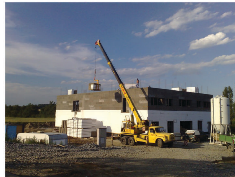
Budova je postavena ze systému ztraceného bednění a tepelné izolace 25 cm.
