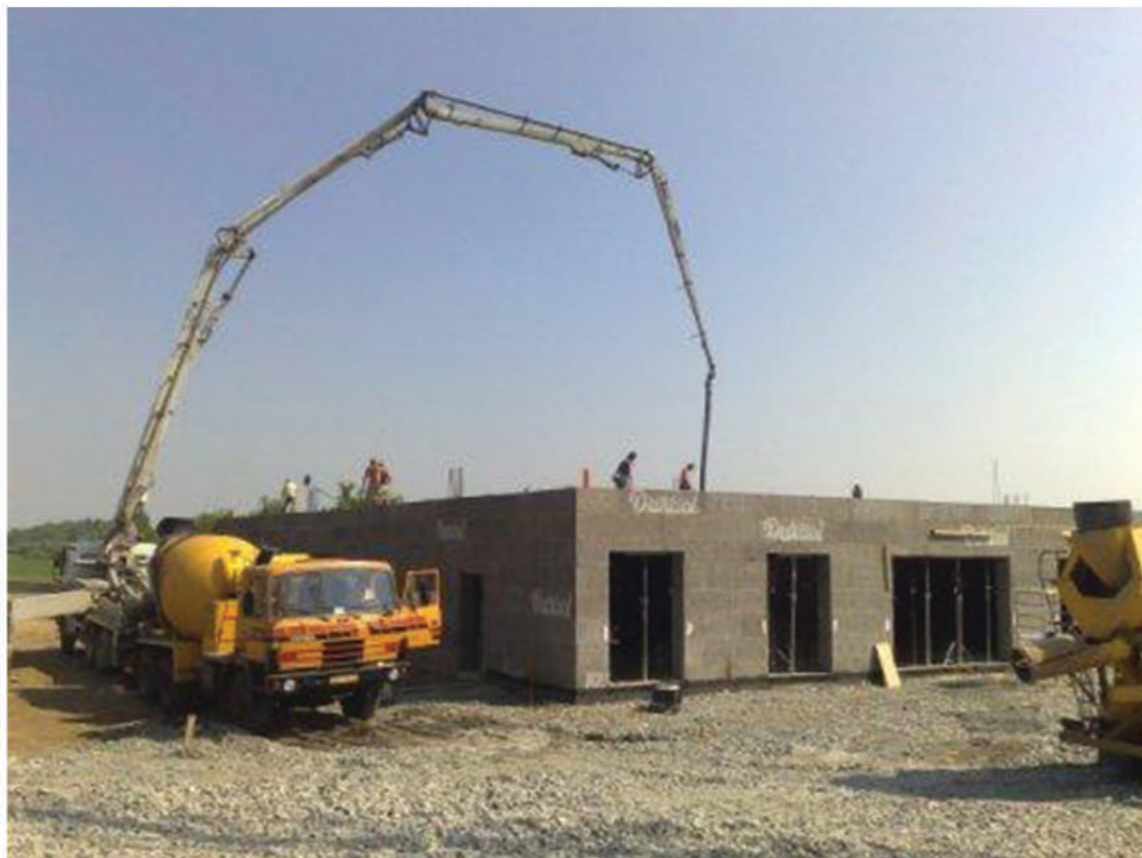
Vetos firemní budova už má první patro! Stěny tvoří systém ztraceného bednění vylitý betonem, stropy jsou betonové monolitické.
